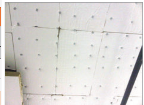
Assemblage à pointe d'acier
