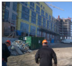
Murs extérieurs - Isolants sur les montants métalliques
