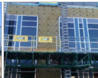
Murs extérieurs - Isolants sur les montants métalliques
