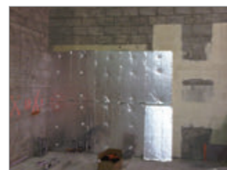
Murs de blocs
