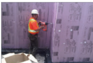
Murs de fondations
