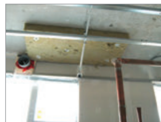
Insonorisation des plafonds
